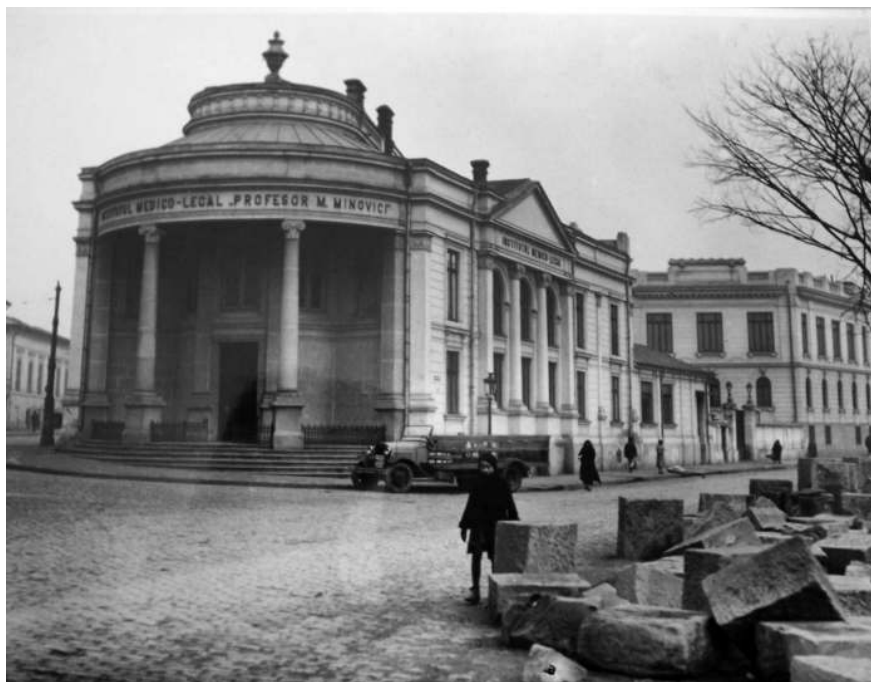
Arhiva MMB. IML la 1930. Cladirea a fost demolată între 1983
